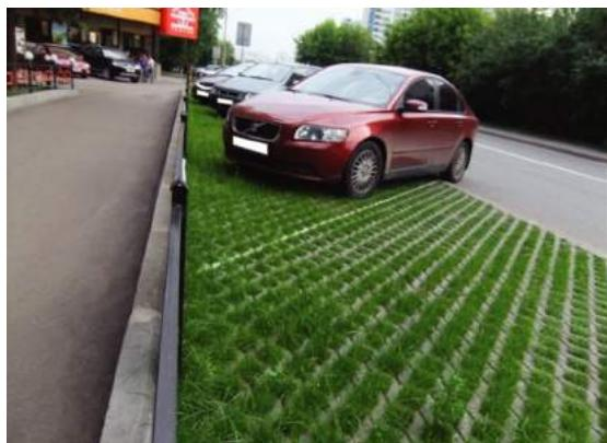
*Рисунок 7. Использование водопроницаемых стоков вдоль дорог*
